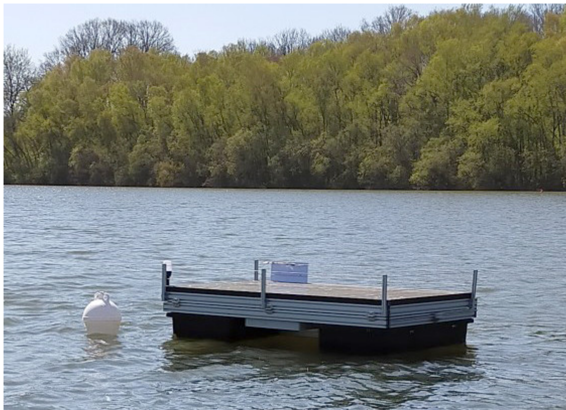
Le caisson flottant doté de panneaux solaires permettant l'alimentation du module
