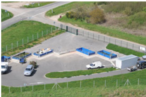
^ Déchetterie de Boutigny-Prouais
