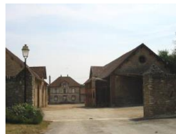
Ancienne ferme à Prunay-en-Yvelines
