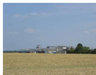
Grande ferme à Boinville-le-Gaillard
