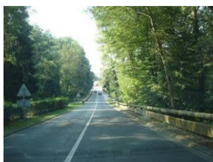
L'entrée de ville de Auffargis
