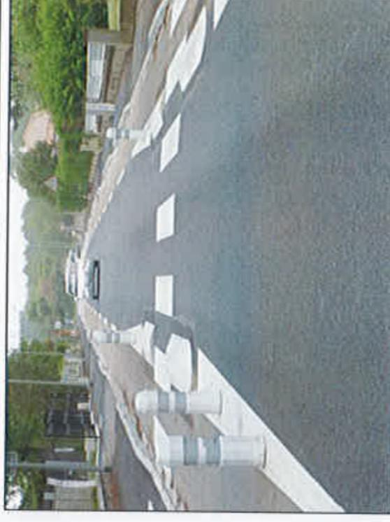
CVCB avec enrobé de couleur différente sur les rives permettant de bien différencier les espaces et écluse dotée de Bypass pour ralentir le trafic motorisé sans contraindre les cycles - CEREMA
