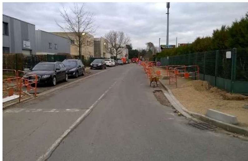
Rue Daguerre : terrassement pour pose de bordures puis aménagement des trottoirs et caniveaux
