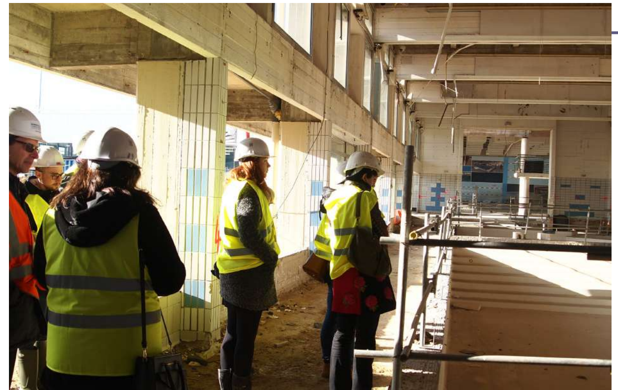
Visite du chantier de la piscine des Fontaines
