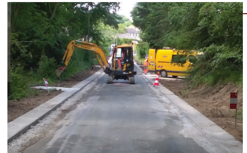
Travaux sur la Transcom 19 (Sonchamp) - Mai 2019
