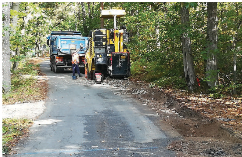
Travaux sur la Transcom 44 (Clairefontaine-en-Yvelines) - Avril 2019
