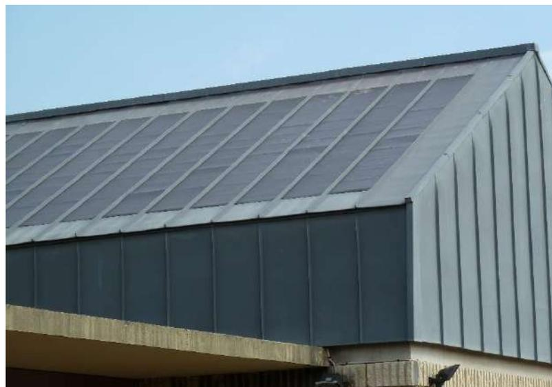
Installation de capteurs photovoltaïques **sur couverture bois et couverture zinc**
