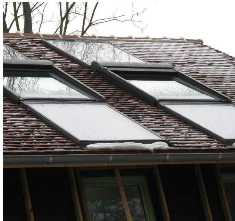
Installation des capteurs dans une **composition d'ensemble, en longueur** dans le sens de la pente
