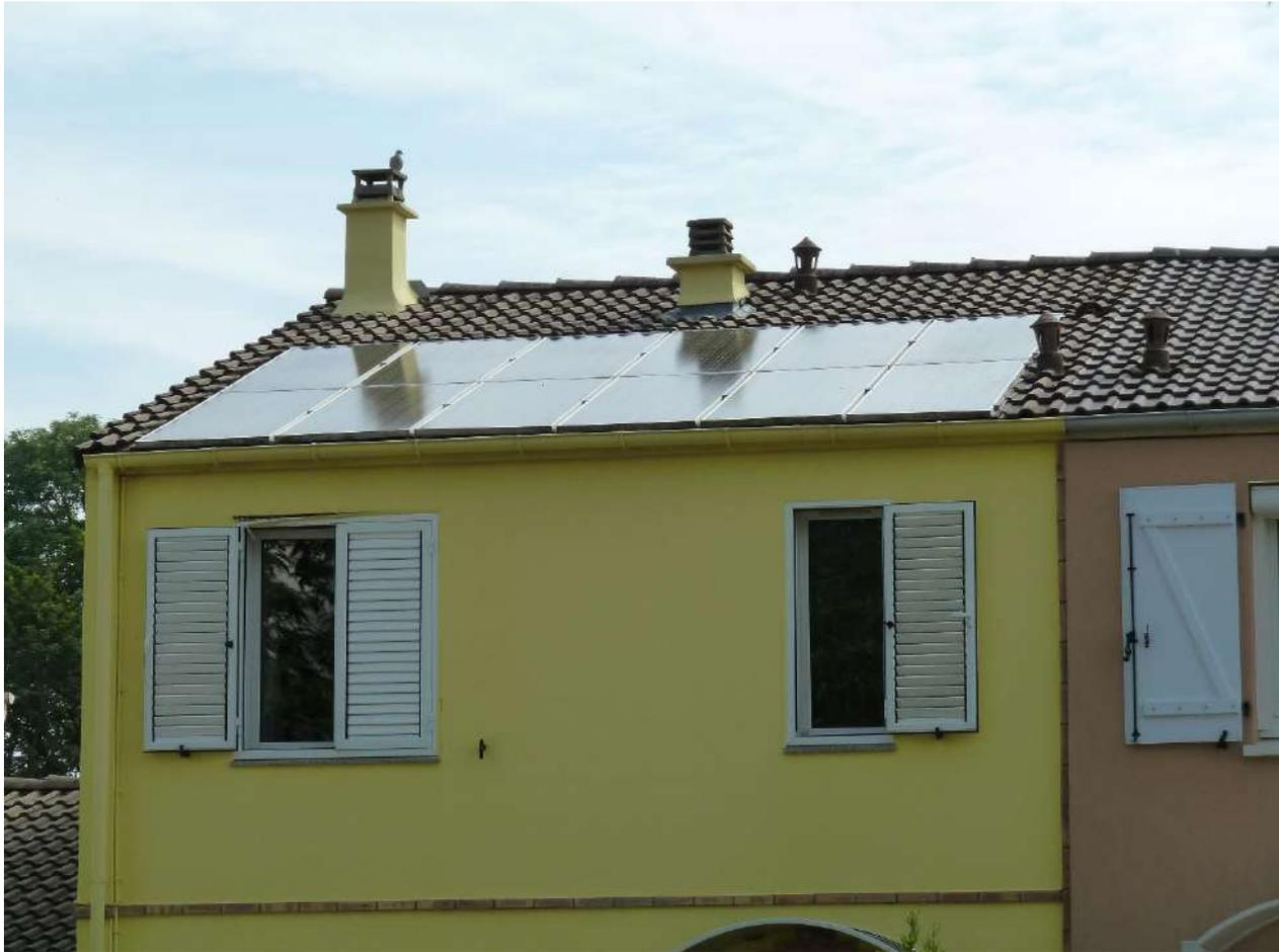
Installation des capteurs dans une **composition en longueur**, parallèle aux lignes principales du toit, situé au **niveau de la gouttière**.
