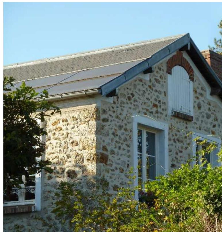
Installation des capteurs dans une **composition en longueur**, parallèle aux lignes principales du toit, situé au **niveau de la gouttière**.
